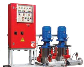
**Область применения:** спринклерные и дренчерные системы пожаротушения, системы с гидрантами, специсполнения для совмещенных хозяйственных и пожарных систем.
